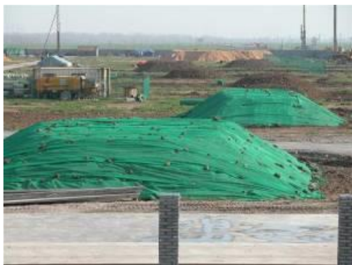
图 4.3-23 制梁场剥离表土苫盖
