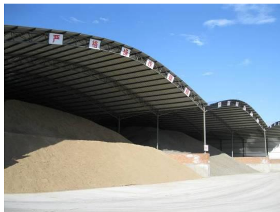
图 4.3-28 拌合站中砂、碎石密闭存放
